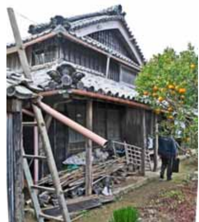
【写真 54 : 背面の状況】
