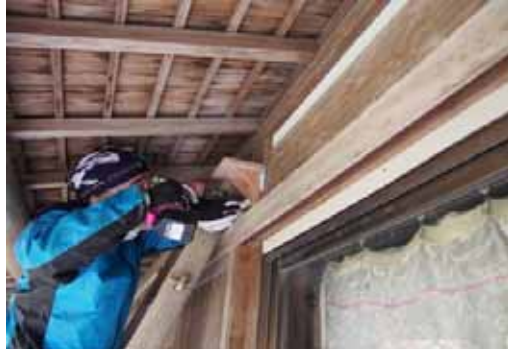
【写真 49：木製台取付け作業の様子】
