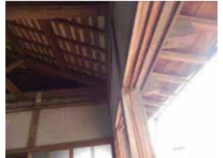
写真 4-5-8 2階：内部と外部の状況
