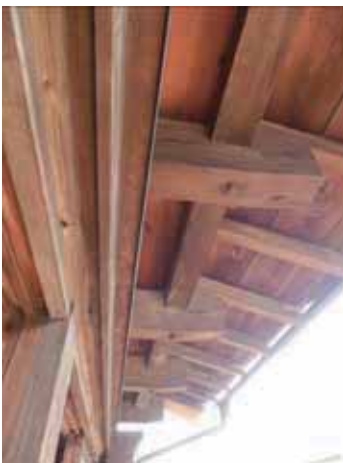
写真 4-5-9 出し桁：装飾的仕様
