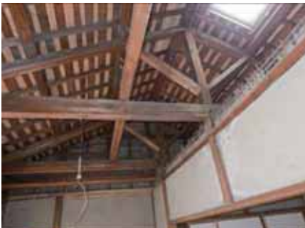
写真 4-5-6 2階：天井を撤去
