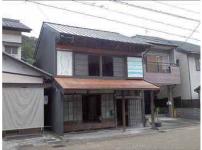
写真 4-5-2 2014.8.29 : 屋根、外壁、2階戸袋を改修
