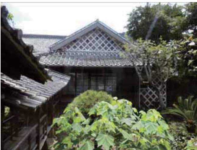
写真 4-2-9 離れから母屋を見る
