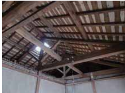
写真 4-5-7 2階は住居として使用予定
