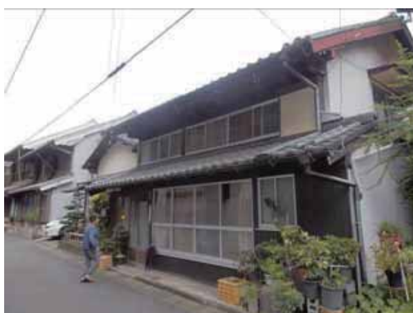
写真 5-14 出し桁形式・勾配が同一の瓦屋根の町並み
