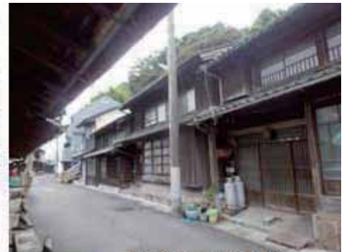
出し桁形式の建築が美しい町並みを形成している
