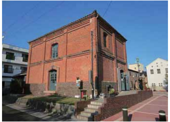
写真 4-7-2 西側から見る
