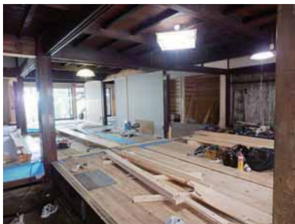
写真 5-19 修復工事 H26.10.4
