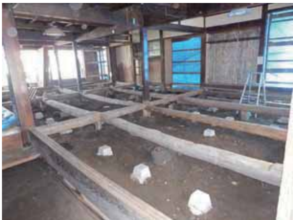
写真 5-18 修復工事 H26.8.4
