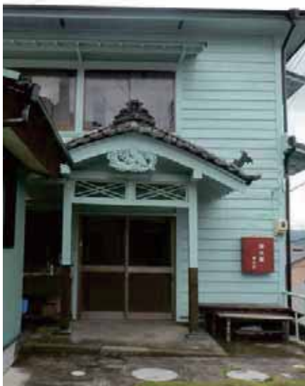
写真 2-8 倉沢公民館玄関の懸魚
