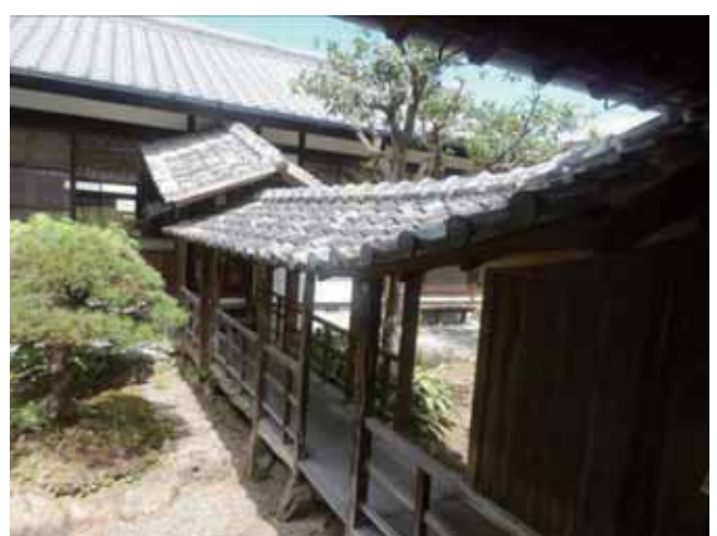
写真 4-2-10 離れへの渡り廊下
