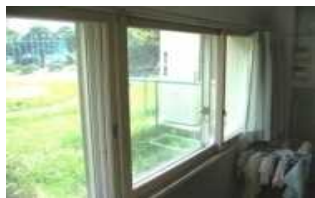
防音サッシ設置
