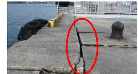
上部工の沈下・目地開き
