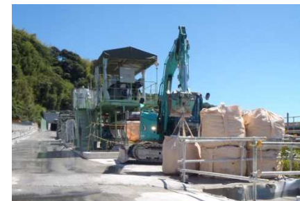
泥土(脱水ケーキ)仮置き状況
