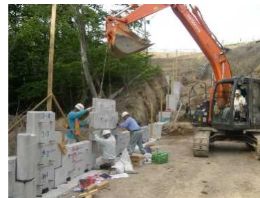
壁面材組立状況
