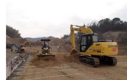
敷均し施工状況
