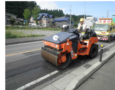
締め固め施工状況
