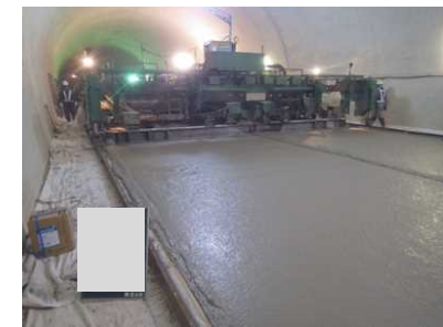
舗設状況(フィニッシャ)
