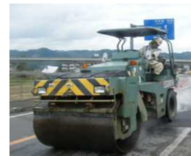
舗装転圧状況
