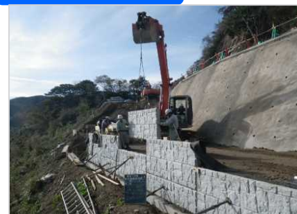
壁面材組立状況
