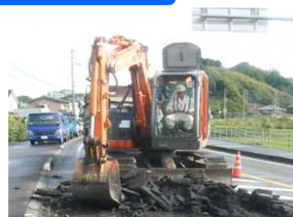
舗装版破碎状況
