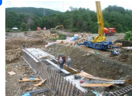
コンクリート打設状況
