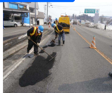
合材敷均し状況
