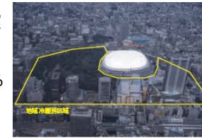
未利用エネルギーの有効活用(東京都文京区) 下水の持つ熱エネルギーを利用した地域冷暖房事業
