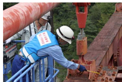
【主桁接合部の近接目視】
