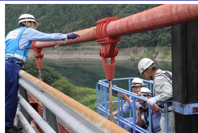
【メインケーブルの近接目視】
