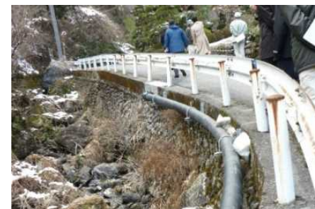
クイック配管(露出配管)
