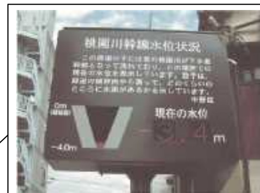
東京都（桃園川幹線）における水位観測・情報提供、水防管理者への提供
