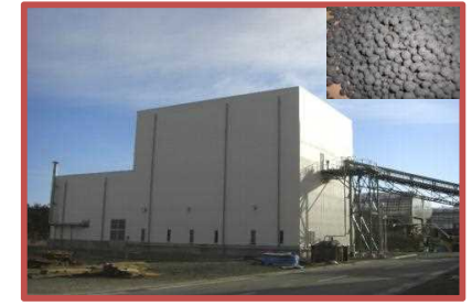
宮城県南浄化センター【造粒乾燥】 （平成21年度より稼働）（50t-wet/日）
