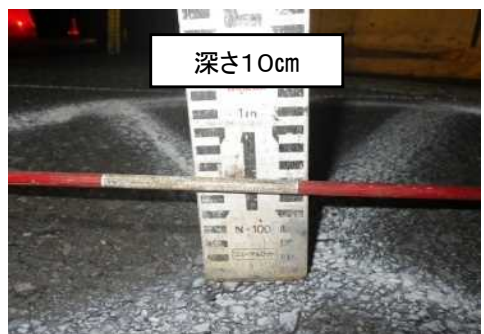
東京都北区での陥没事例(平成25年8月)
