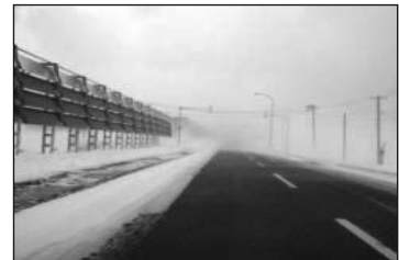
防雪柵の設置
