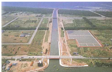
石狩放水路完成(S57)
