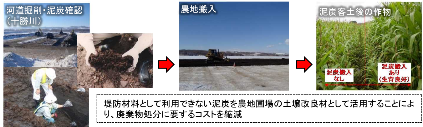
十勝川改修工事の内 育素多地区南二十線地先河道掘削工事(H23～24年度実施)
