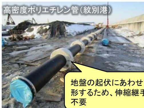
紋別港岸壁(-4.5m)改良その他工事(H22年度実施)
