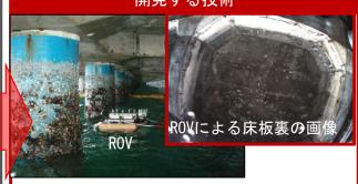
遠隔操作可能なロボット技術(ROV)に よって, 効率的に劣化状況を確認
