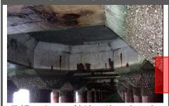
目視によって錆汁の染み出しを 確認することによって鉄筋腐食 状況を把握
