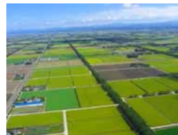
国営農地再編整備事業「中樹林地区」工事着工(H12)
