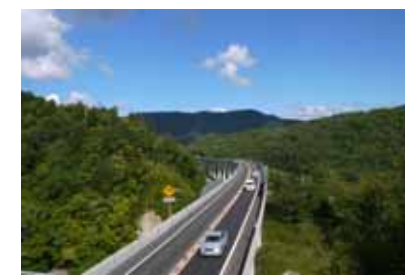
道東自動車道(夕張IC～占冠IC)供用(H23)
