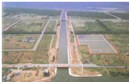
石狩放水路完成(S57)
