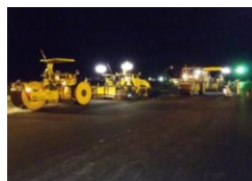
(老朽化した滑走路舗装の改良)
