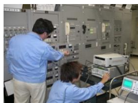
(航空保安施設点検実施状況)
