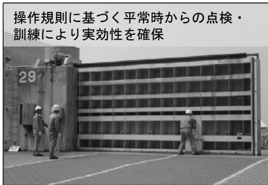
【現場操作員による陸閘閉鎖:大阪港海岸】
