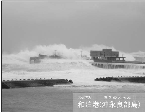
【港内静穏度確保のための防波堤】
