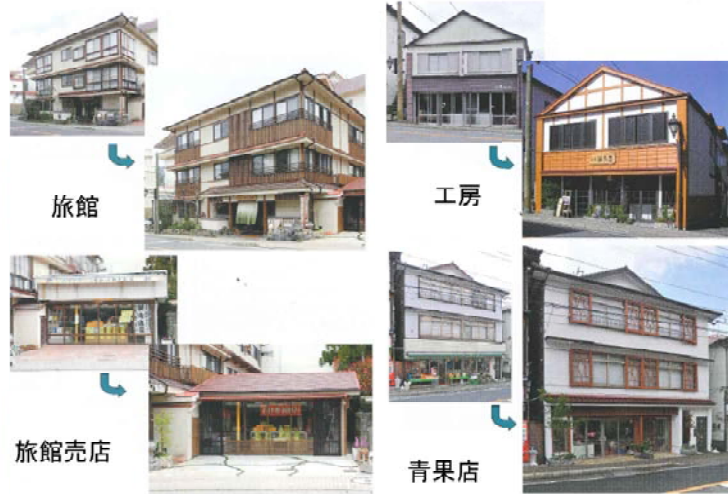
ファサード改修事例
