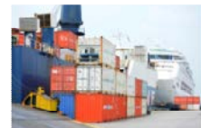
大型船用岸壁の状況 (貨物船と旅客船の岸壁競合が発生)
