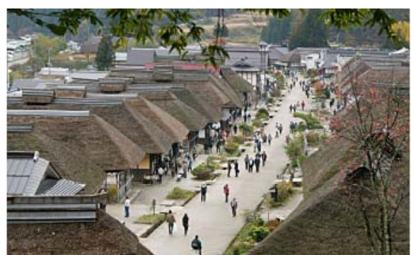
【裏通りへの電線配置により表通りを無電柱化 (福島県南会津郡下郷町大内宿)】
