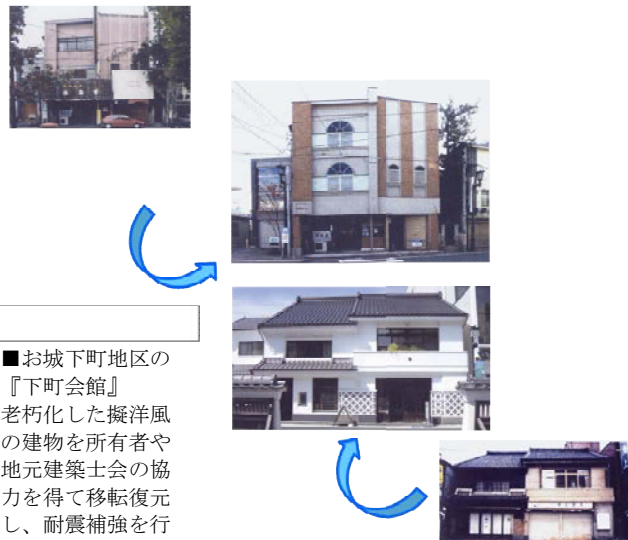
ファサード改修事例
