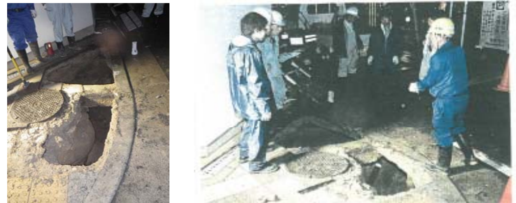
大阪府豊中市での陥没事例(平成25年9月)
