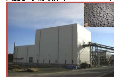
宮城県県南浄化センター【造粒乾燥】 （平成21年度より稼働）（50t-wet/日）
