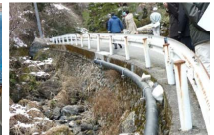
クイック配管(露出配管)
