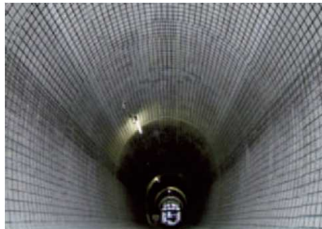
高強度炭素繊維グリッド、ポリマーセメントモルタルによりトンネル補強
