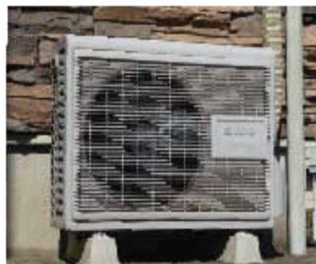
空気熱源ヒートポンプ
