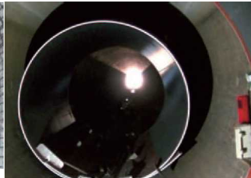
サイホン内に鋼管を挿入し補強
