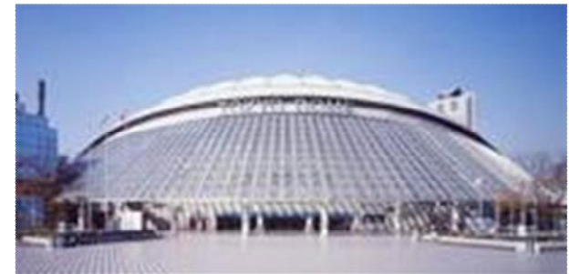
出典：株式会社東京ドームHPより
