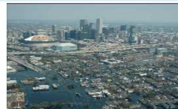
【ダウンタウンの浸水状況】 (円形の建物は一時避難地にもなっていたルイジアナスーパードーム)
