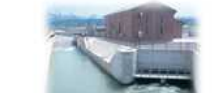
七ヶ用水発電所(手取川水系手取川)
