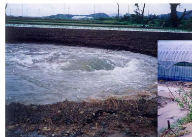
伊良湖サイホン漏水状況
