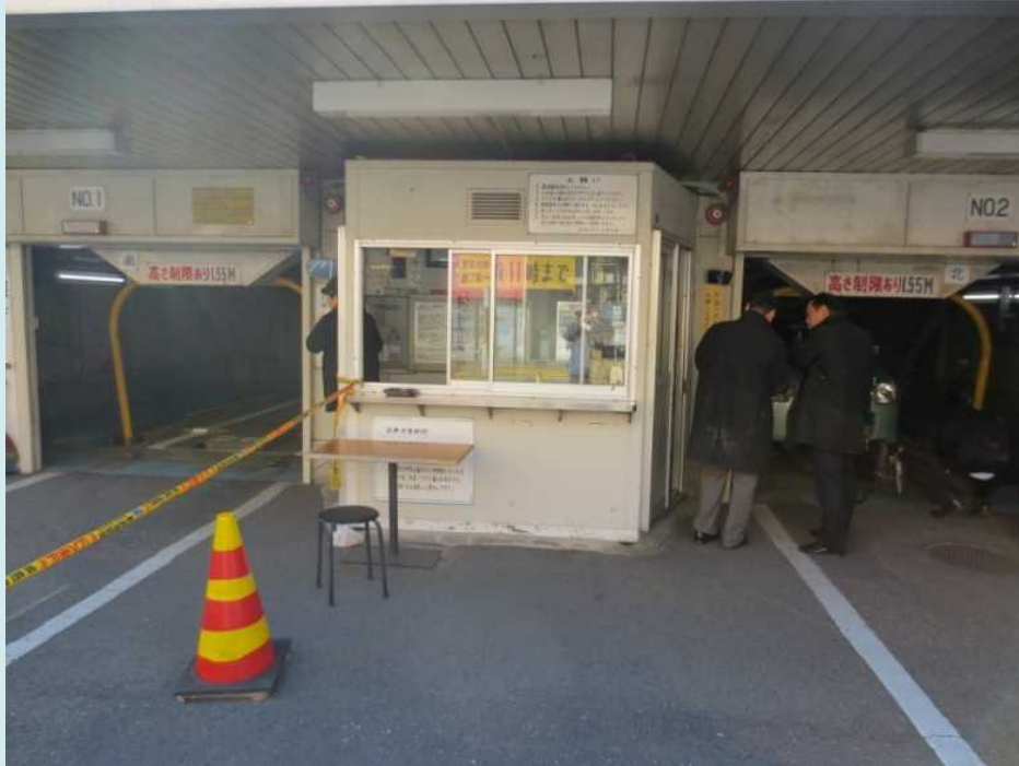
運転者の死亡事故事例(確認不足・センサー故障)
