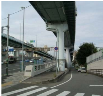
国道2号と側道の状況
