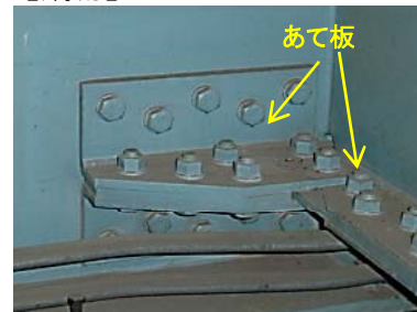
疲労補強(あて板設置)
