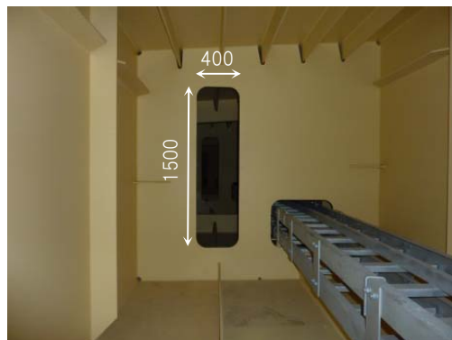
鋼桁内部ダイヤフラム開口部の形状 (点検員が通行しやすい形状)
