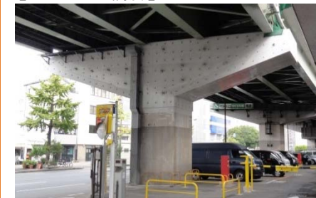
鋼板による補強・表面保護
