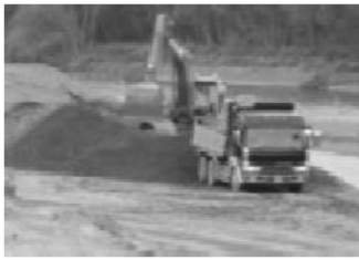
十勝川河道掘削
