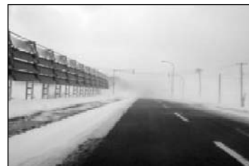
防雪柵の設置
