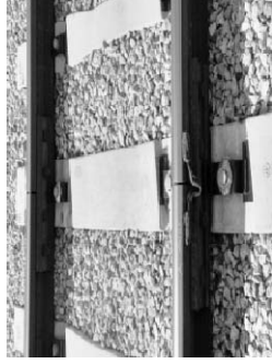
線路設備 (軌道改良(PCまくら木化))
