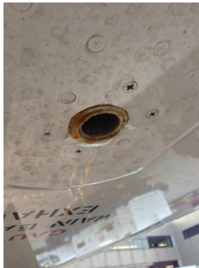
排気口周辺の外観
