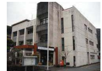
老朽化した公共施設
