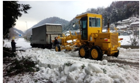
除雪車両による車両牽引状況
