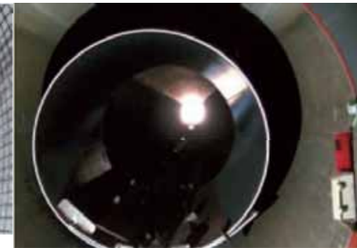
サイホン内に鋼管を挿入し補強
