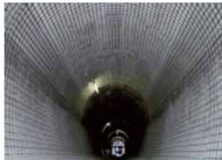
高強度炭素繊維グリッド、ポリマーセメントモルタルによりトンネル補強
