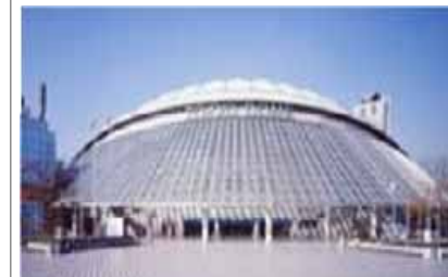
雨水利用施設の事例
