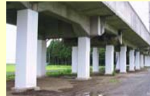
高架橋の耐震補強
