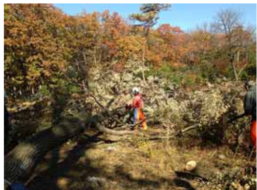
写真 5-3-2 伐採後の枝払い
