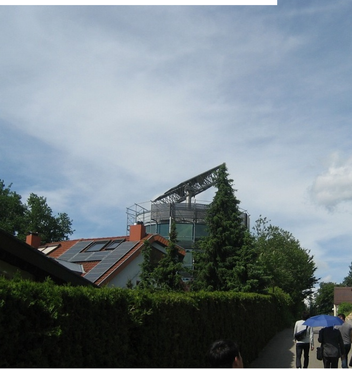
●ヘリオトープ プラスエネルギー地区の設計者の住宅。 日射などの影響を計算してエネルギー的に最も効率のよい状態になるように回転するユニークな設計。
