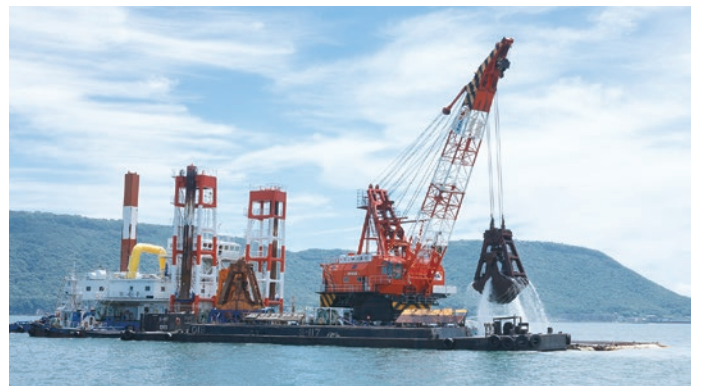
朝日地区沖では大型船運行のための浚渫工事が行われている。土砂の取り方は備讃北航路の現場とは異なる
