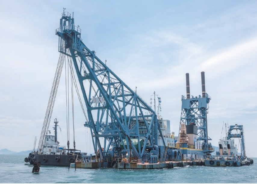
坂出港から船で約30分。広島沖の浚渫工事現場（ポンプ浚渫船千代田丸）
