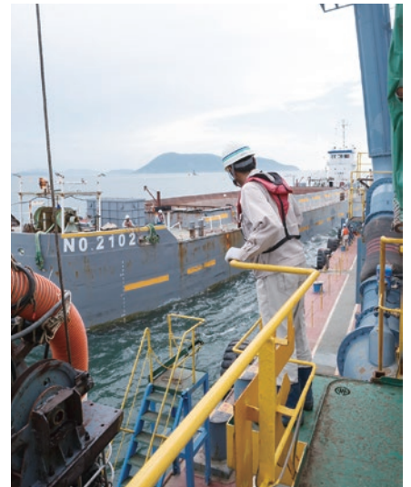
土運船がいっぱいになると、海上で待機していた次の土運船がすぐに横付けされる
