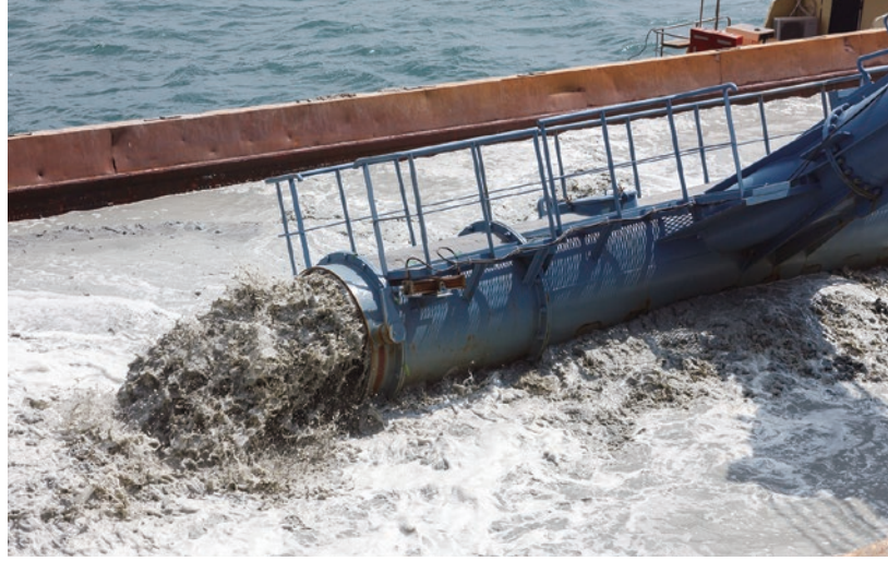
土運船の船倉に吐き出される海水と土砂。船倉には仕切り壁を設け、浚渫土を堆積させ余剰水を還流ポンプで吸入。吸入された水はカッタードリルが掘削する海底と流れていく
