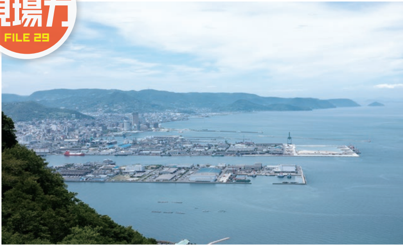
屋島から望む高松港。浚渫現場で吸い上げられた土砂は高松港朝日地区の埋め立て現場で使われる（写真中央右寄りの部分）
