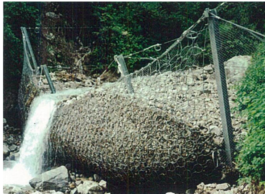
土石流の捕捉状況
