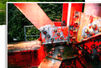
主桁の腐食
