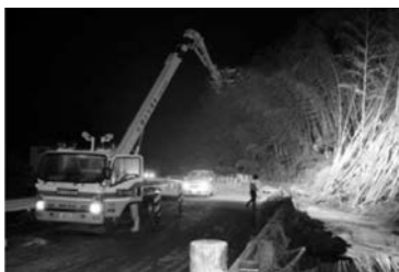
照明車による夜間作業支援状況
