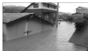
高知県 いの町 仁淀川水系の氾濫状況
