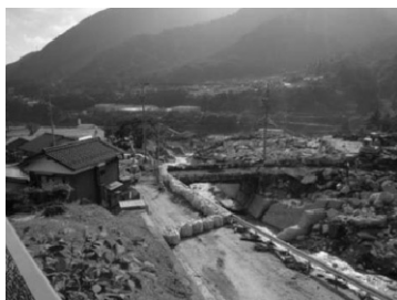
民家、生活道路への越水防止のため、大型土のうを設置
