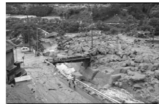
長野県 南木曾町 土砂災害の状況
