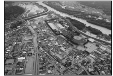
京都府 福知山市 由良川水系の氾濫状況
