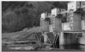
東日本大震災における堤防、水門の破壊
