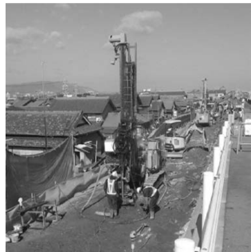
締め固め工法による液状化対策（三重県桑名市）
