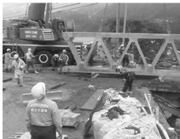
被災した県道 264 号梨子沢橋の仮橋仮設の技術支援
