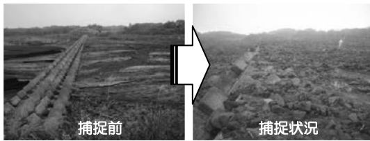
遊砂地工による流出土砂の捕捉状況（大沢川遊砂地）
