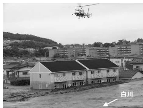
被災状況（熊本県熊本市）
