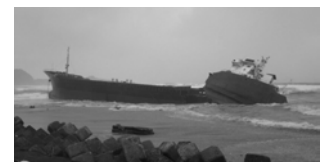
海岸保全区域内での船舶の座礁
