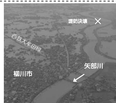
矢部川の被災状況（福岡県柳川市）
