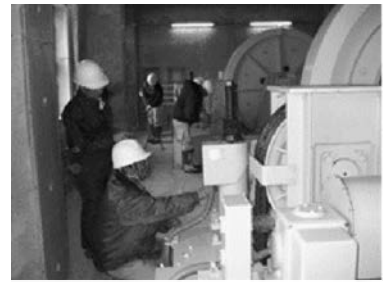
ダム放流設備点検状況
