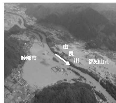
由良川（中流部）の被災状況（京都府福知山市、綾部市）
