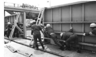
陸閘の閉鎖作業
