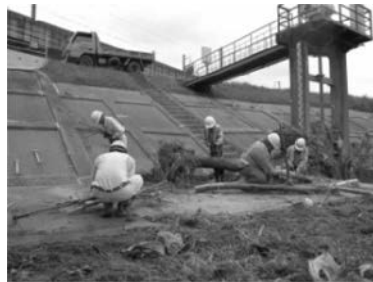
樋門吐口に堆積した塵芥の処理
