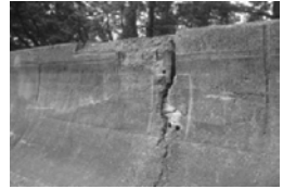
鋼矢板の腐食・コンクリートの劣化、堤防のひび割れ
