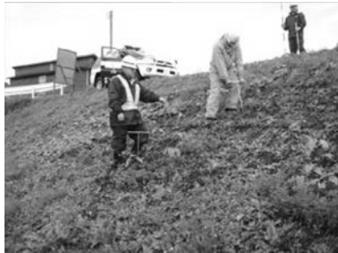
堤防点検状況
