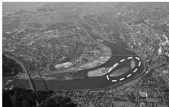
中州の土砂堆積状況
