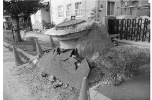
液状化により隆起したマンホール（浦安市）
