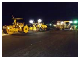
（老朽化した滑走路舗装の改良）
