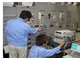
（航空保安施設点検実施状況）
