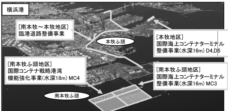
【平成26年度 横浜港実施中プロジェクト】
