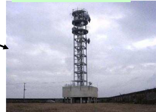
浦安レーダー (千葉保安部管理)
