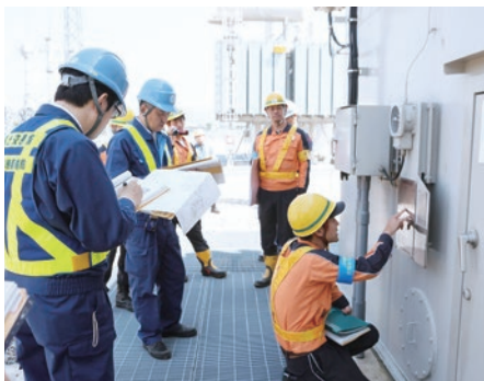
設備機器の銘板を読み上げ、工事の計画と設備に相違がないかを確認
