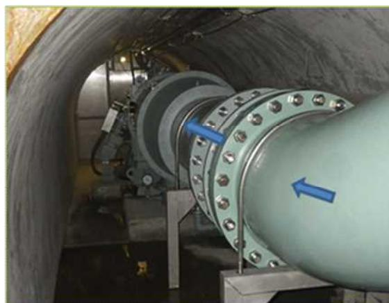
写真-2 初瀬水路取水塔小水力発電設備
