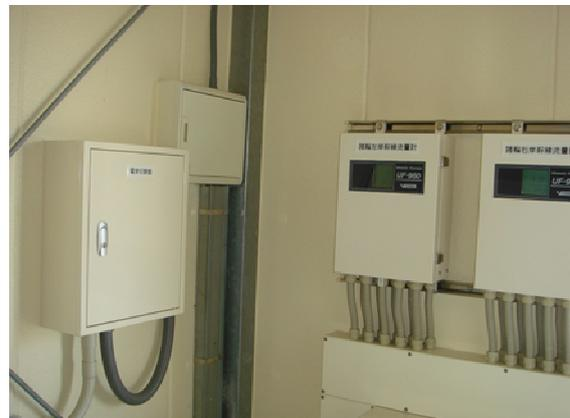
写真-4 太陽光発電設備から非常時に電源を供給する愛知用水の流量計機器
