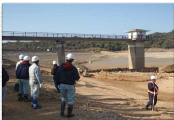
写真-3 初立池耐震対策工事の現地研修
