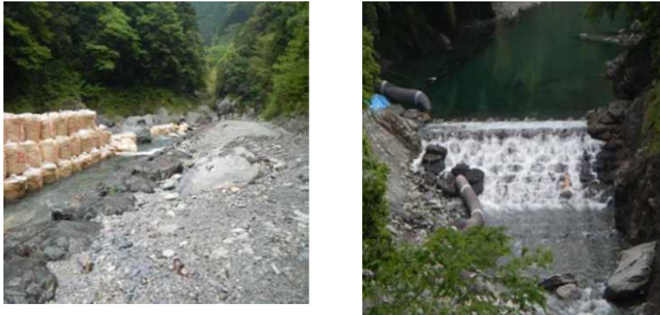
流路護岸状況（平成25年5月）
