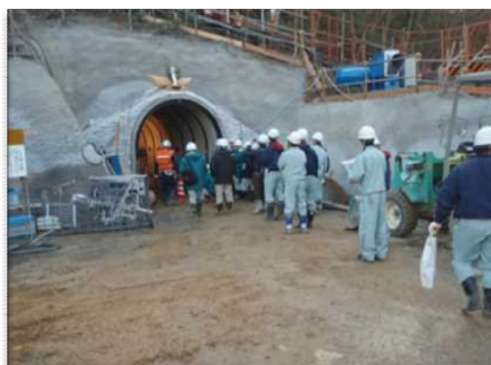
写真-4 トンネル新設工事の現地研修
