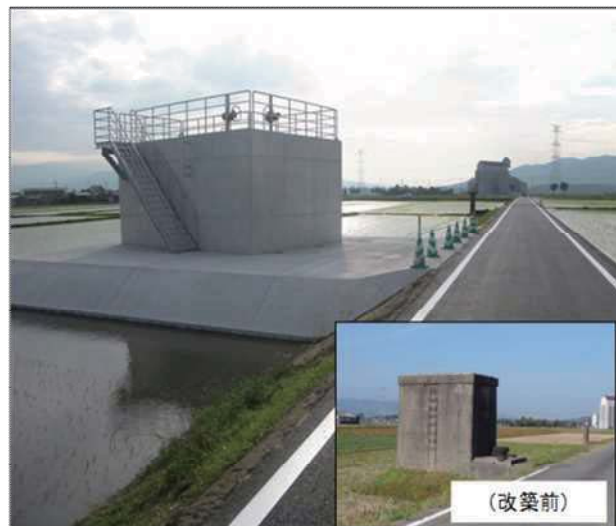
写真-8 減勢工改築状況 【夜須第3減勢工改築工事】
