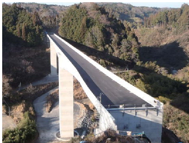
写真-3 付替県道工事 (猫また大橋) 実施状況 (川上ダム)
