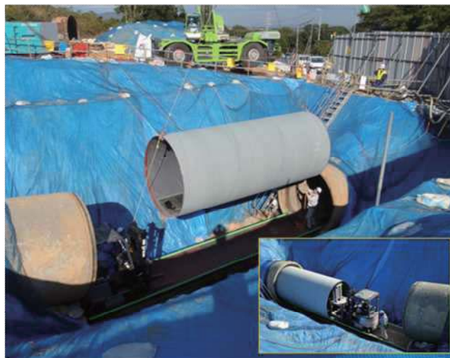
写真-6 内挿鋼管の吊り込み・挿入状況 【高松サイホン改築工事（耐震補強）】
