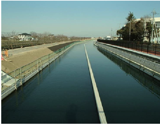
①上流部改築工事状況
