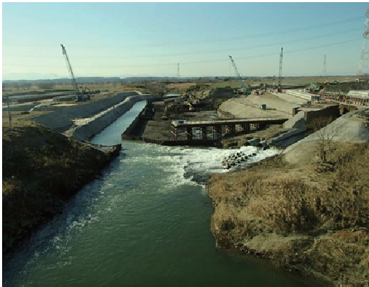
③下流部改築工事状況
