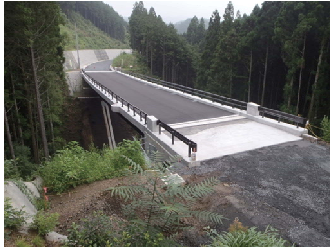
写真-1 付替県道工事（7号橋梁）実施状況（思川開発）
