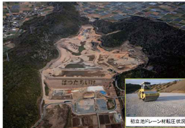
写真-7 初立池耐震補強状況 【初立池耐震補強工事（耐震補強）】
