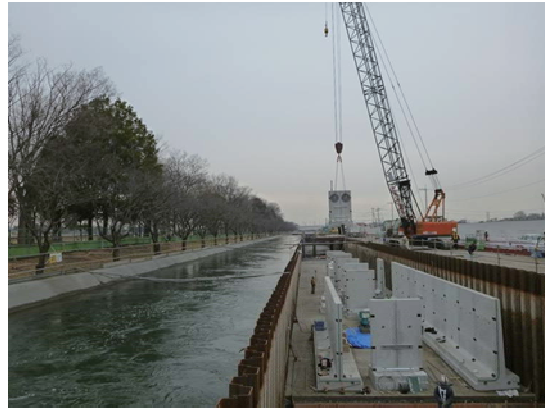
②中流部改築工事状況
