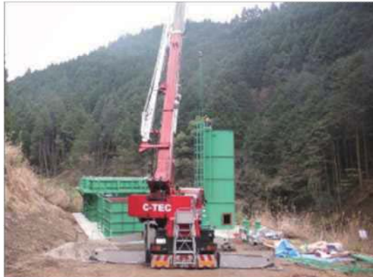
仮排水路トンネル工事状況（仮設備設置）
