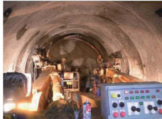
水浦水路トンネル工事状況（支保工建込）
