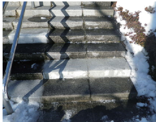
写真－2 一般利用者の安全確保のための補修（阿木川ダム）
