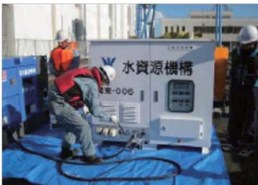
⑤ポンプパッケージ（10m 3 /min級）配線中
