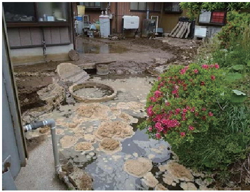
①通水停止後の漏水箇所
