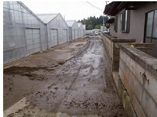
②流出した泥土
