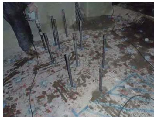
鉄筋挿入工
