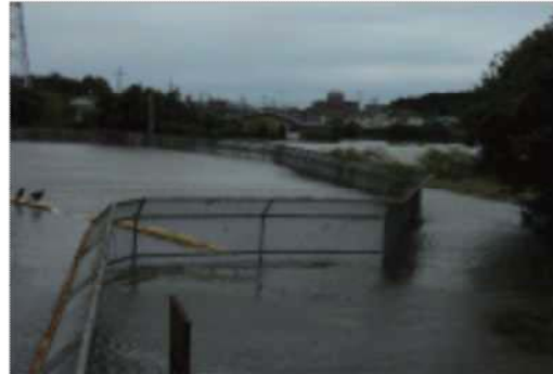
②岩戸地区干拓地周辺の湛水状況
