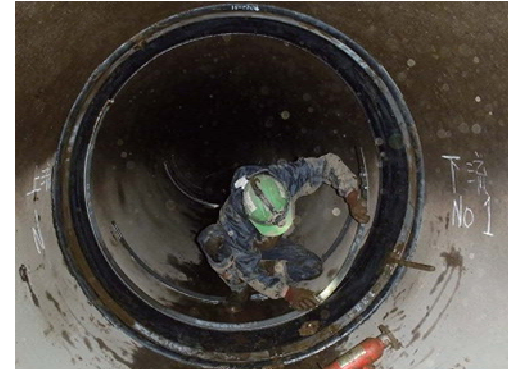
⑥継手補強材設置（備蓄資材使用）
