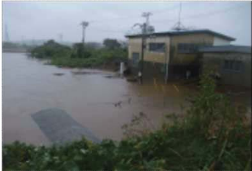
①臼井第二機場周辺の湛水状況
