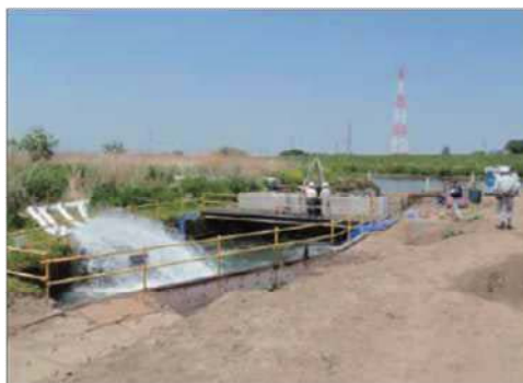
③ポンプ車による給水状況
