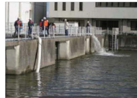
⑥ポンプパッケージ実送水確認
