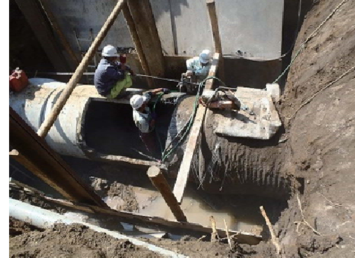
④既設PC管撤去状況
