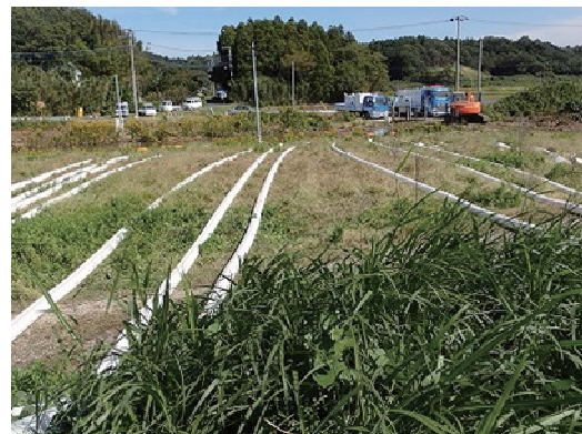
⑥岩戸集水路でのポンプ車配備状況（2）
