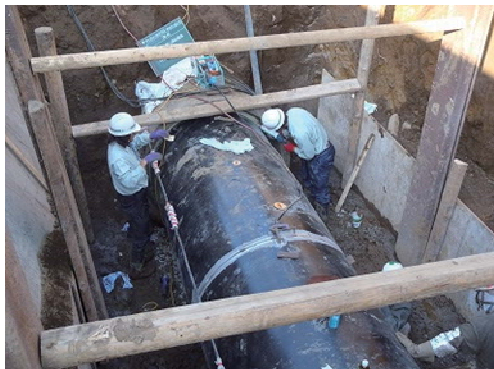
⑤鋼管設置（備蓄資材使用）
