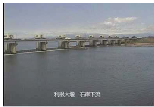
監視画面（大堰下流）
