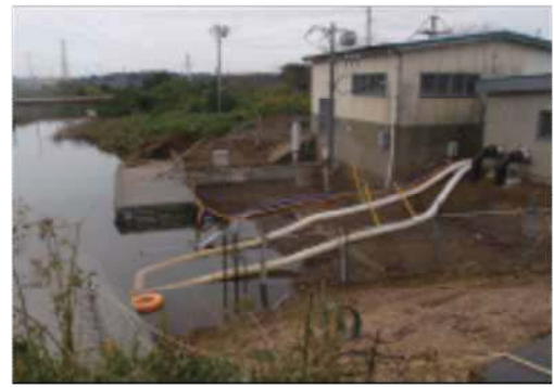
④ポンプパッケージによる排水作業
