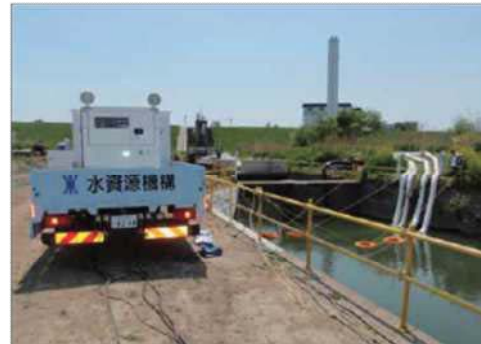
②ポンプ車配備状況
