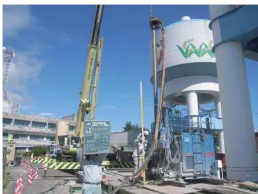
弥富揚水機場都市用水サージタンク (高圧噴射攪拌工)
