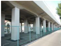
東武伊勢崎線高架橋
