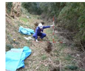
TEC-FORCEによる緊急点検・対策
