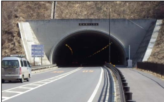
付替国道145号 (平成23年12月に全線供用開始)
