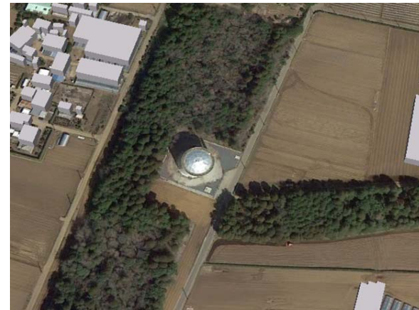
林地に建設し日影の影響を回避した事例
