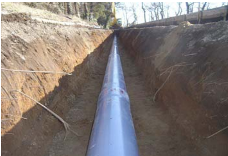
①パイプライン施工状況(塩ビ管 φ300)
