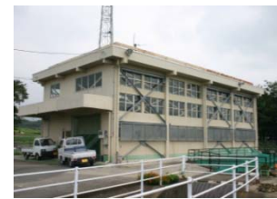
揚水機場(農水専用)
