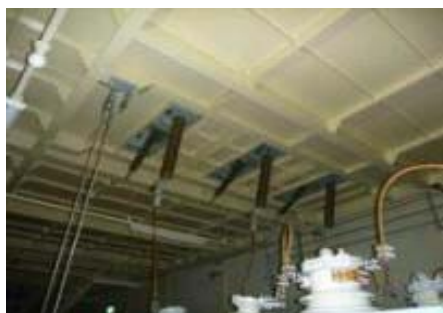
大網特別高圧受変電設備の断路器破損
