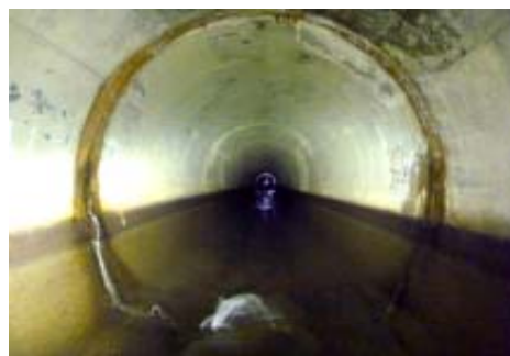
トンネル構内
