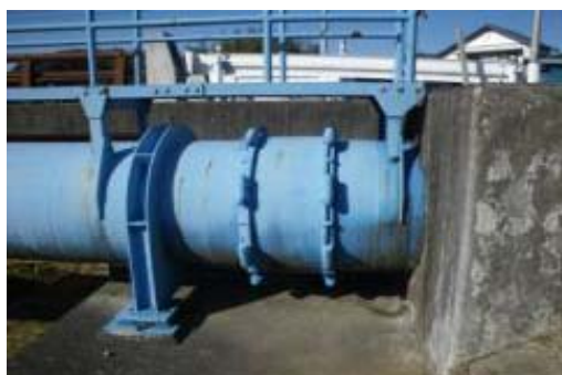
水管橋橋台部
