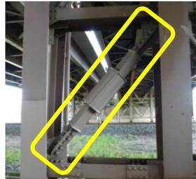
鋼材降伏系ダンパーの設置例
