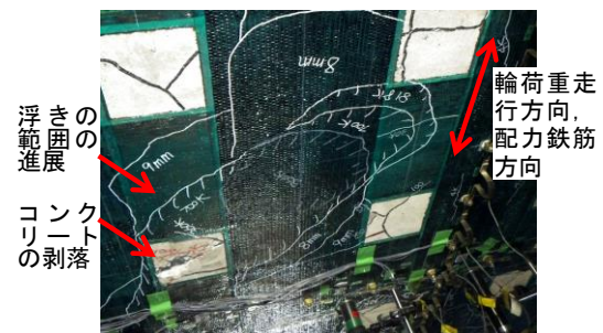
補強前後の床版下面におけるコンクリートの主鉄筋方向ひび割れのひび割れ幅の変化(上)と輪荷重走行試験における床版下面の疲労損傷(下)
