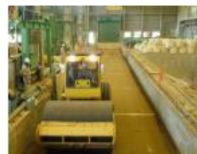
転圧試験の状況 (大型機械)
