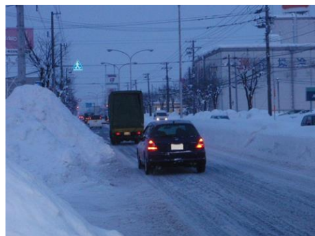
路肩雪堤による有効幅員の減少
