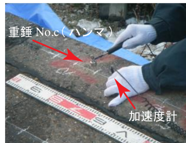
現地での床版上面調査の状況
