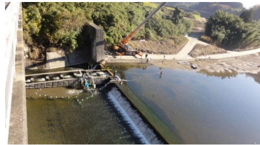
現地実証試験実施状況全景
