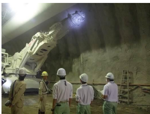
写真-1.5.2 トンネル工事現場見学
