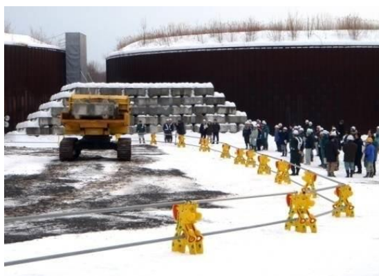
写真-2 無人クローラックによる運搬作業
